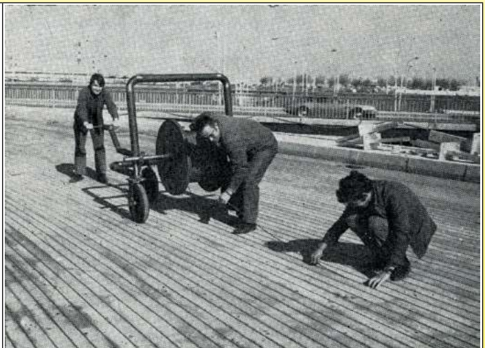
1968, Installation des Heizbandes auf einer Zufahrtsrampe zu einem Busparkplatz, Flughafen Orly bei Paris ( Elektrische Fußbodenheizung, von Robert Félix, 1971, Ultimheat Museum* )
